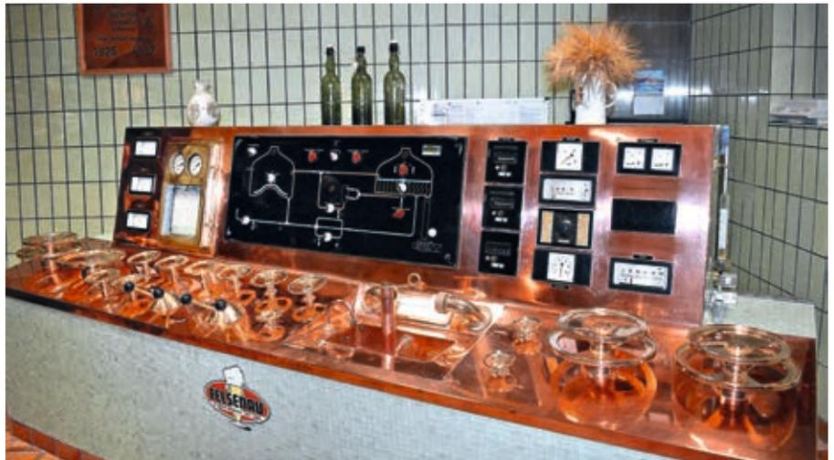
Alte Steuerungsanlage, die digitale Steuerung befindet sich direkt dahinter und ist so nicht sichtbar. (Foto: Simon Scheidegger)
